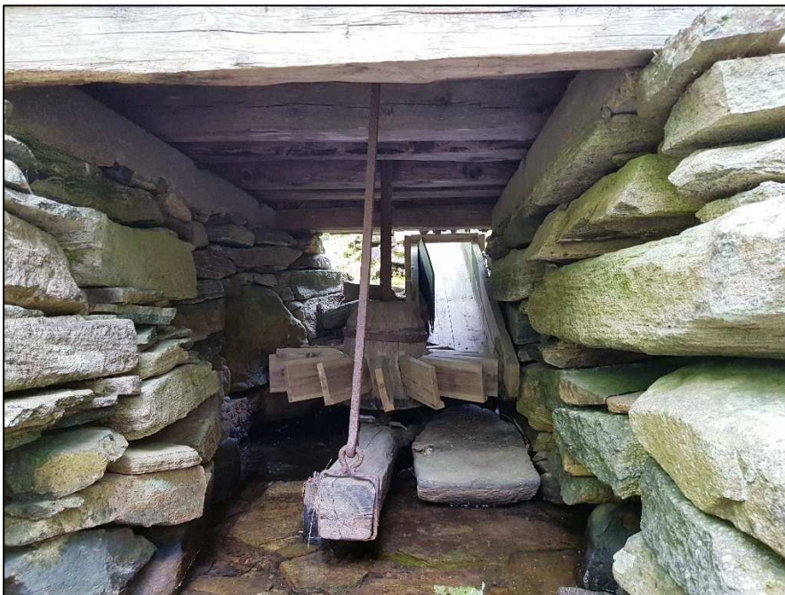
Fig. 32 – Kvarnrännan och skovelhjulet. Som framgår av rännans storlek och placering krävs det förvånansvärt små vattenmängder och endast en måttlig fallhöjd för att driva kvarnen. (foto: Carl Persson)
