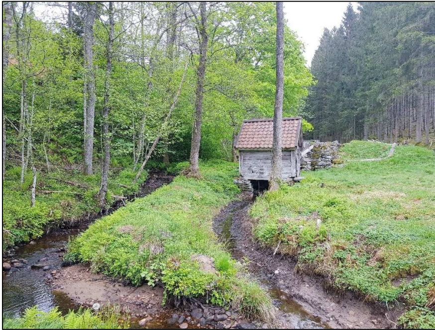
Fig. 31 – Som framgår av bilden förutsätter inte användandet av skvaltkvarnar ett konstant kraftigt vattenflöde i vattendraget. Uppströms kvarnen återfinns dock två dämmen som användes för att samla vatten inför kvarnarnas brukande. (foto: Carl Persson)
